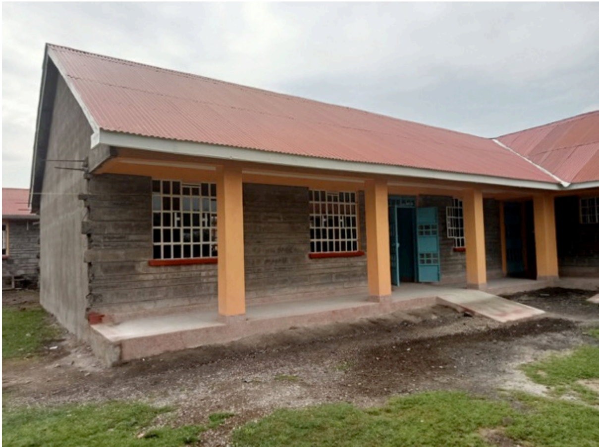
Die fertiggestellte Schneiderei
