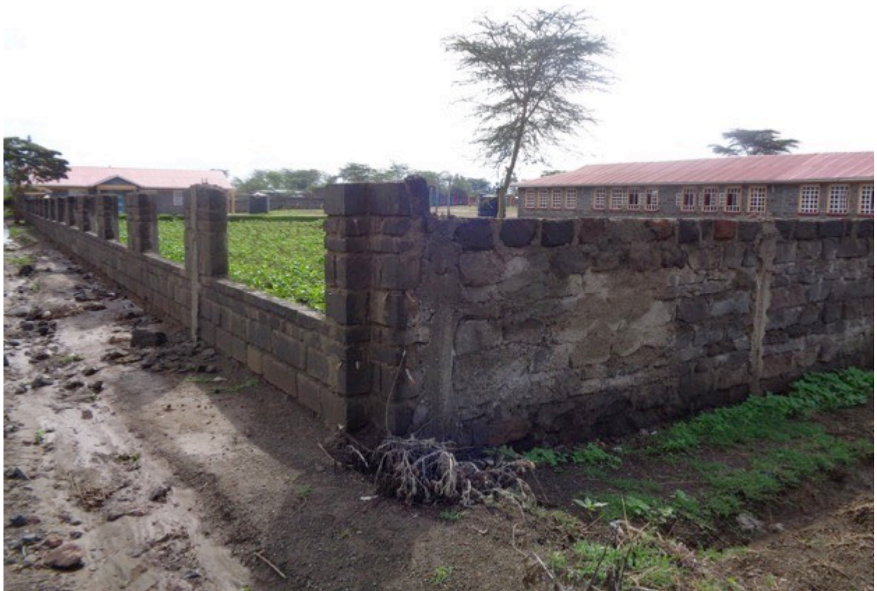
Eine komplette Mauer um unsere Schule – es fehlen nur noch die Metallgitter zwischen den Säulen.
