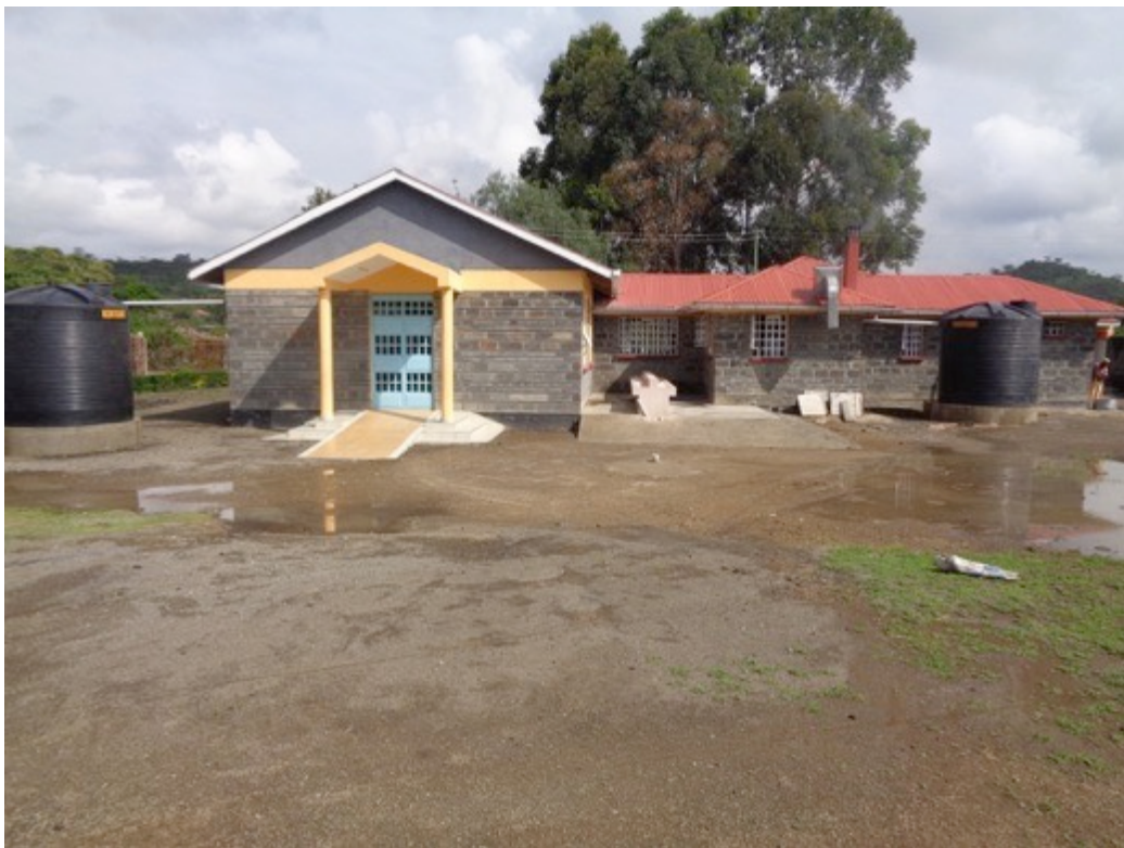
Unser fertiggestellter Speise – und Mehrzwecksaal, die Küche und die Wassertanks zum Regenwasser - Sammeln
