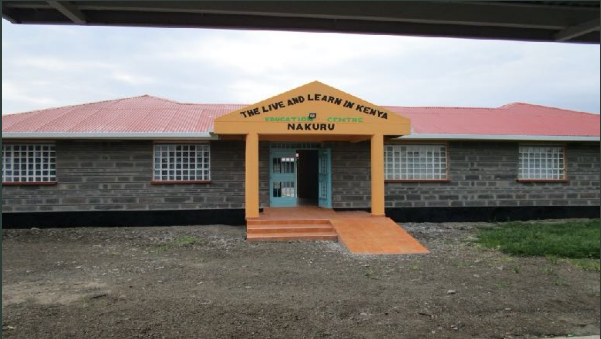
Live and Learn in Kenya - Administrationsgebäude
