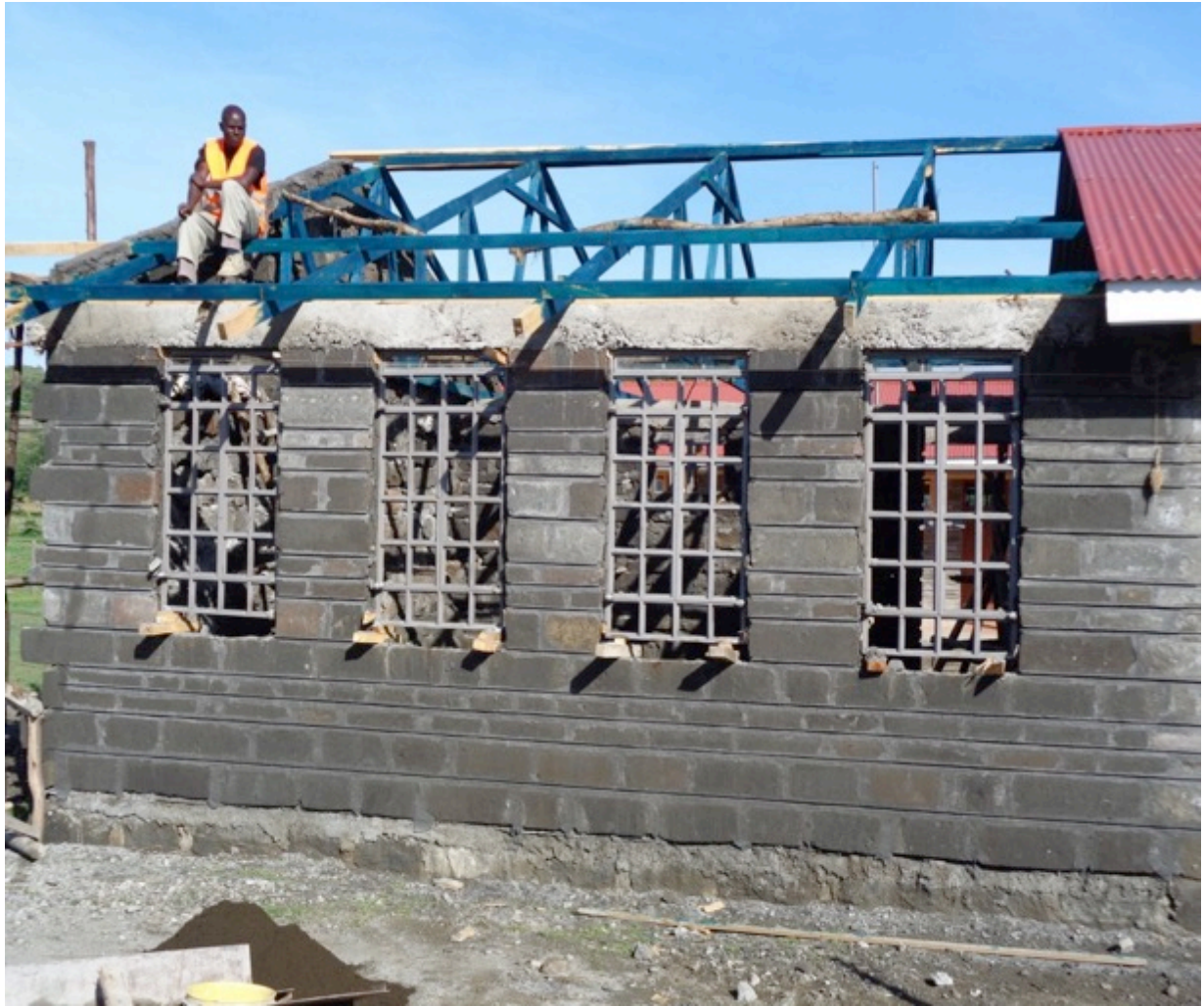
So sah der Rohbau Ende April aus
