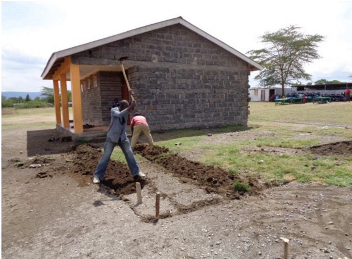
Ausgrabung für die Fundamente am 6. April
