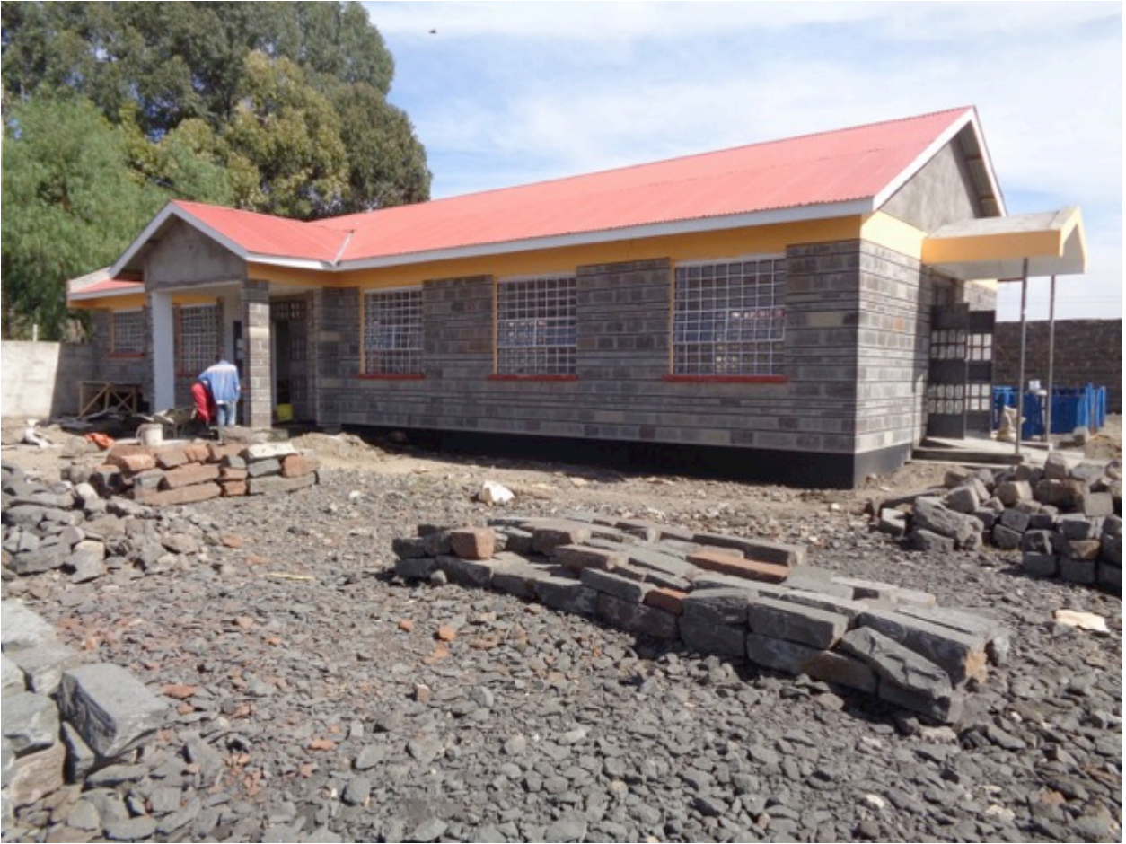
Baufortschritt bei unserem Speisesaal
